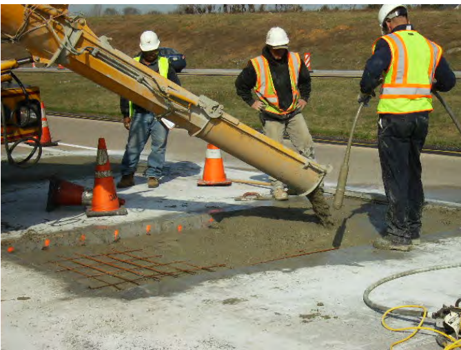
Pouring New Concrete
