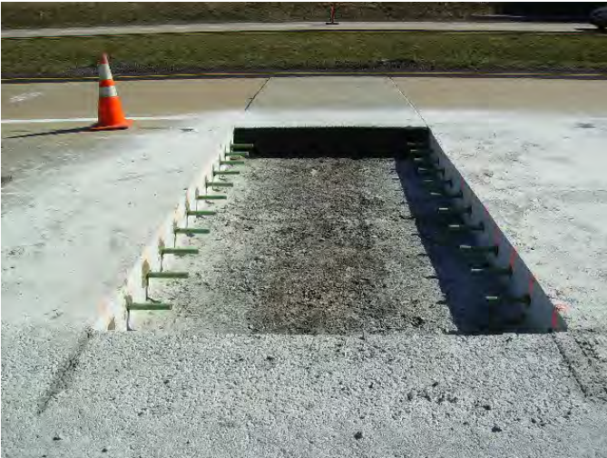
Replacement Section Prepped For Pour
